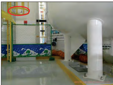
桶槽爬梯加裝鎖頭鎖固
