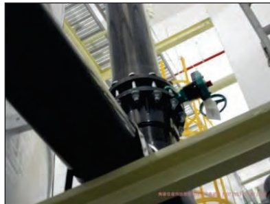
溢流管加裝遮斷閥
