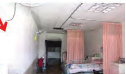
防火區劃非起火側 相對安全區之住房
