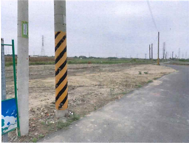
圖(1)、未設置交維設施(含警示燈)
