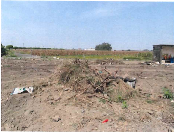
圖(7)、工地垃圾未清理
