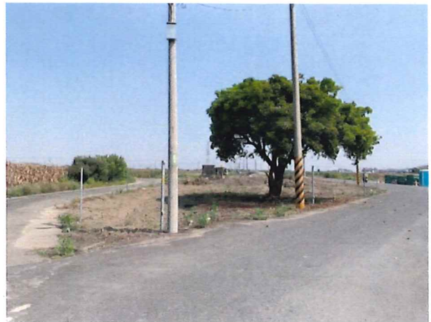
圖(2)、未設置交維設施(含警示燈)
