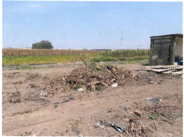
圖(8)、工地垃圾未清理
