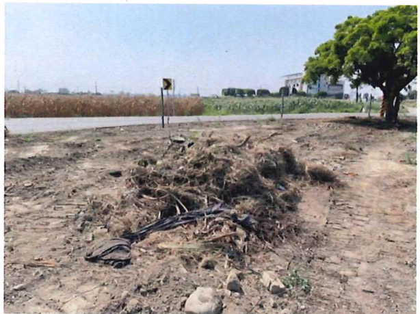
圖(10)、工地垃圾未清理
