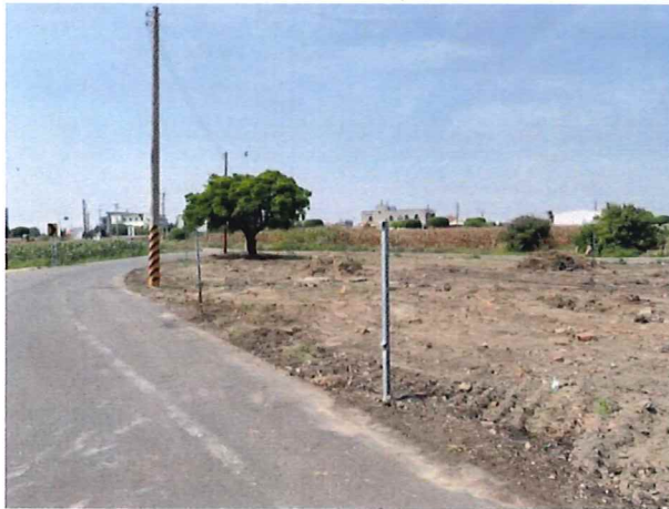
圖(3)、未設置交維設施(含警示燈)
