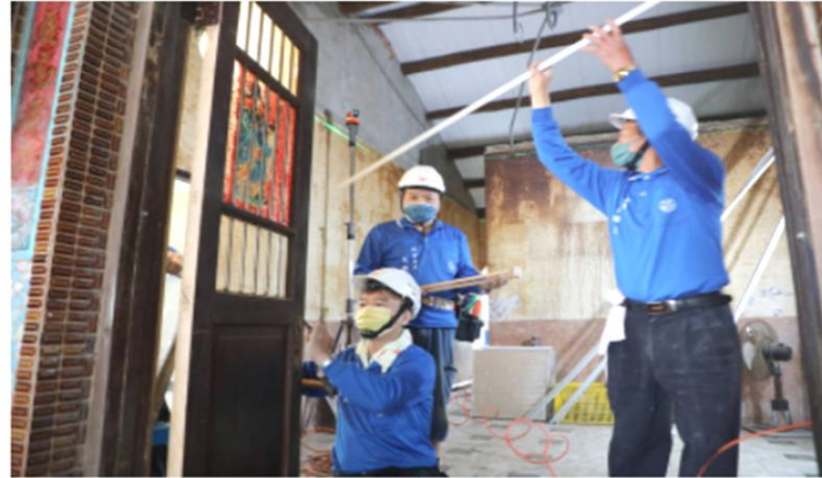
台南市「做工行善團」利用清明節，協助弱勢家庭修繕房屋。（圖由台南市政府提供）
