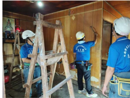
梅雨季將屆，台南做工行善團加速為弱勢屋補漏，今兵分多路前往統觀區、棕腳區、安定區修繕，同時整修二手傢俱提供弱勢家庭所需。(圖由台南市勞工局提供)
