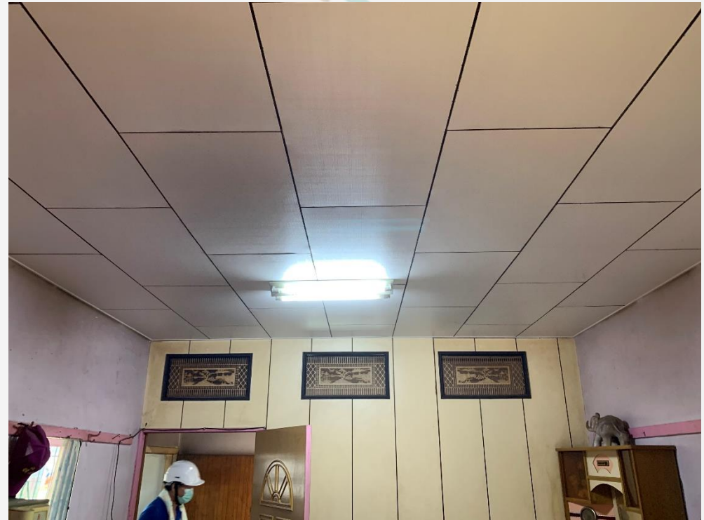
天花板及照明修繕後
