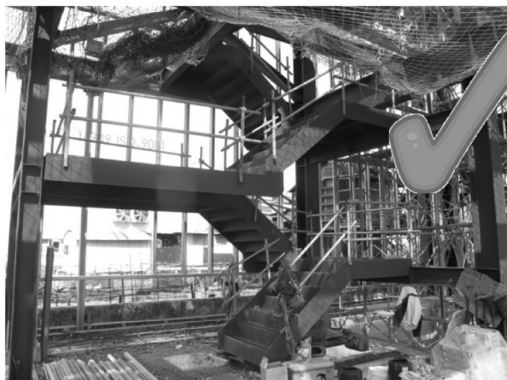
樓梯開口已設置護欄
