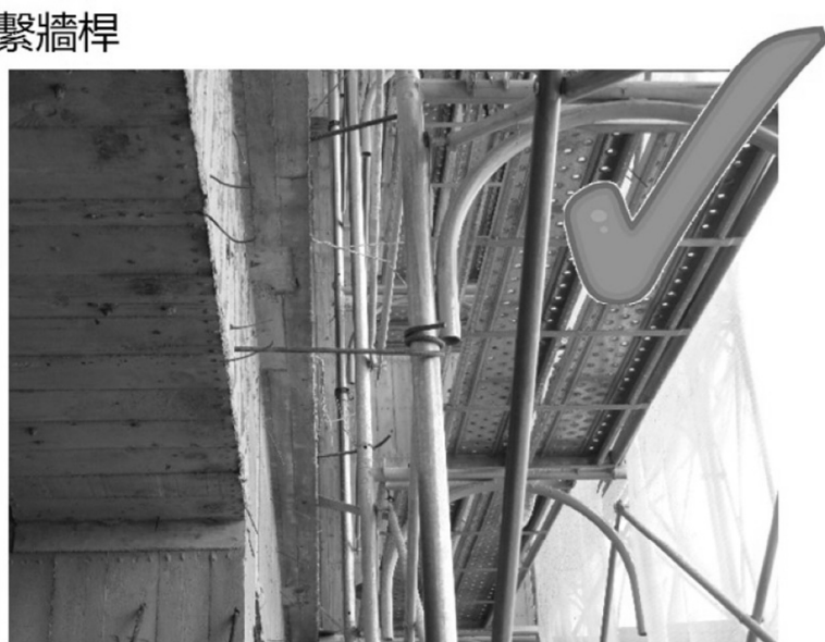
施工架已設繫牆桿繫結固定於建物
