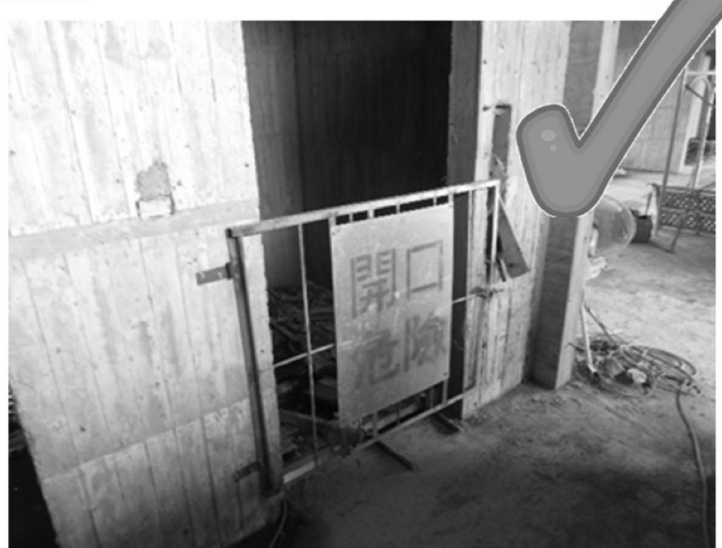
電梯口開口已設置護欄
