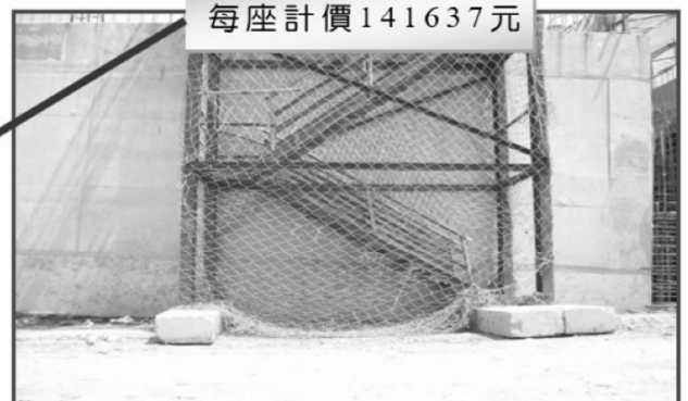
型鋼式上下設備施作照片
