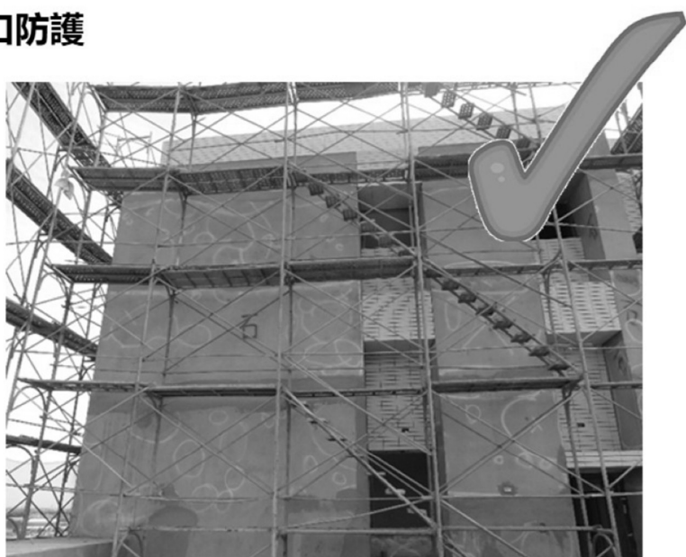
施工架開口已防護(內外交叉拉桿及內外下拉桿)
