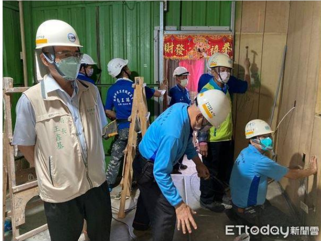
▲台南做工行善團志工，不畏艷陽酷熱，分別前往安南區2戶、官田區、下營區弱勢戶進行修繕服務。(圖/記者林悅翻攝，下同)
