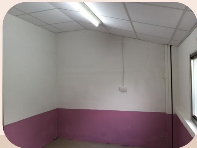
天花板修繕後
