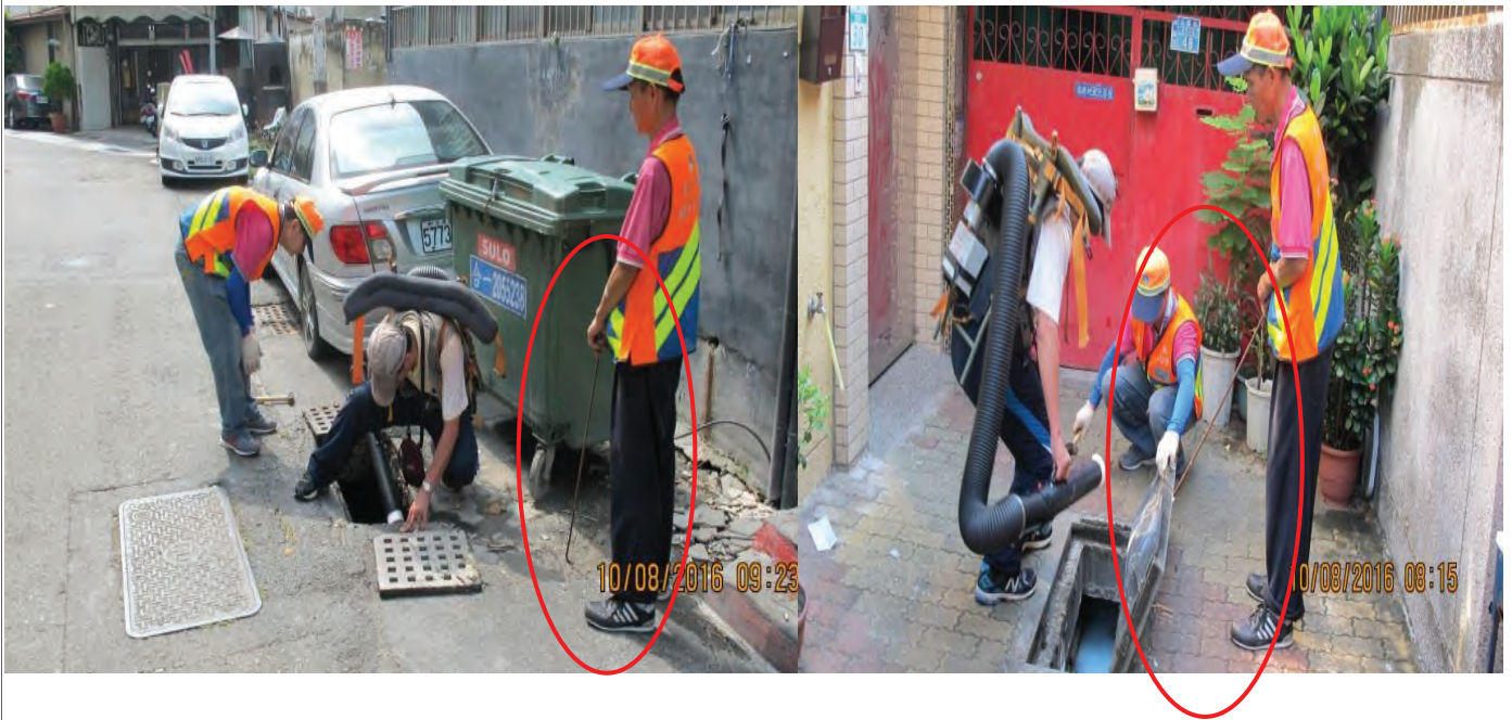
起勾手協助(排水溝渠)
