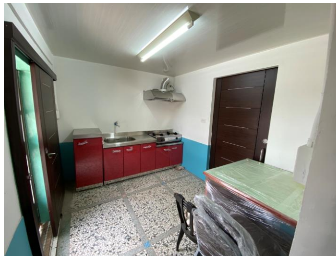
修繕後(增設廚房)
