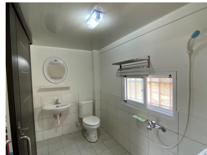
修繕後(增設廁所)
