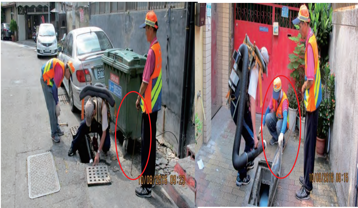
起勾手協助(排水溝渠)
