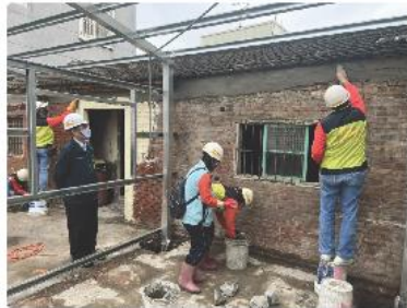
勞工局做工行善團不畏寒冷，到將軍區為弱勢修屋，勞工局長王壽嵩(右四)到場為志工加油打氣。(勞工局提供)
