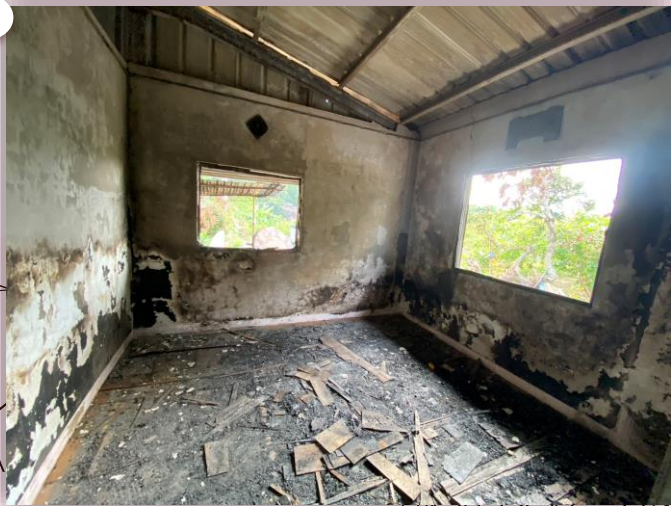
外側房間修繕前
