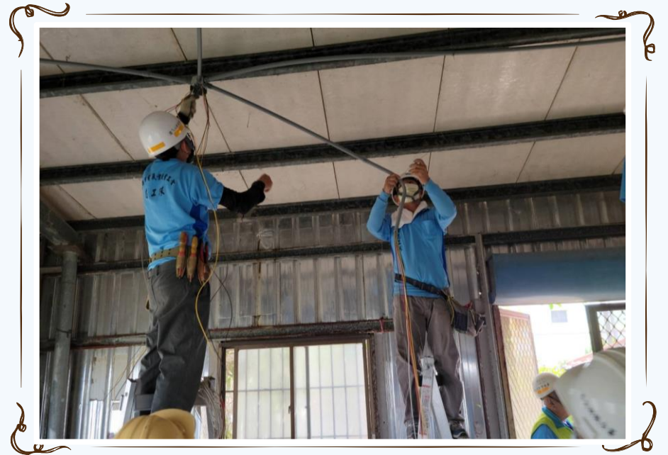
電氣志工施作
