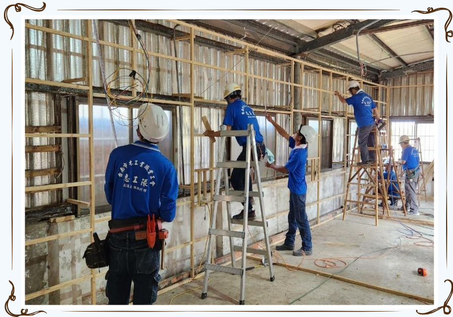
木工志工施作
