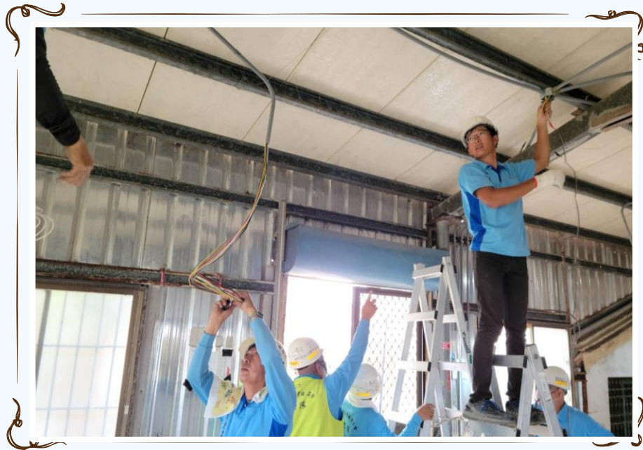
電氣志工施作
