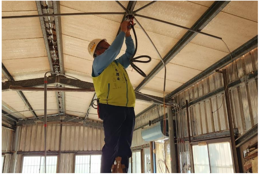
電氣志工施作
