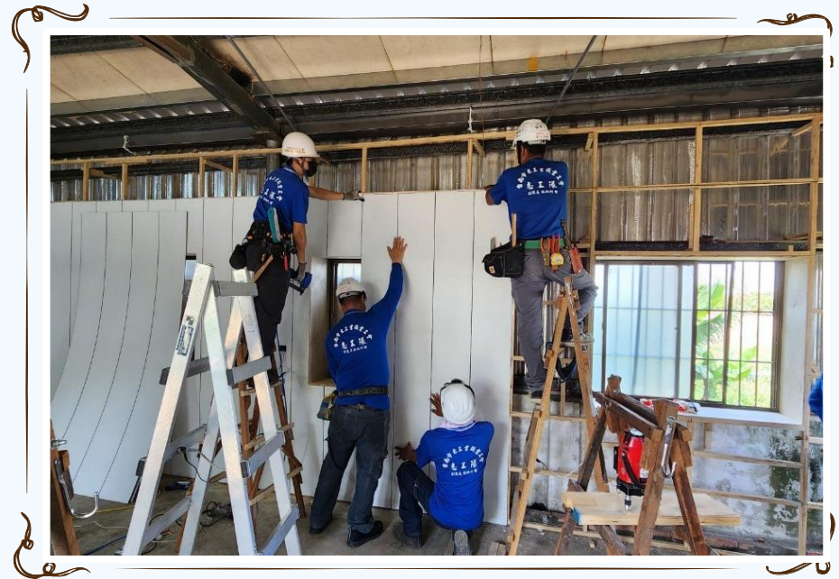
木工志工施作
