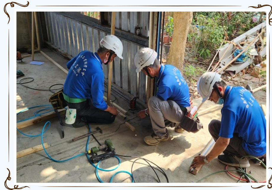
木工志工施作
