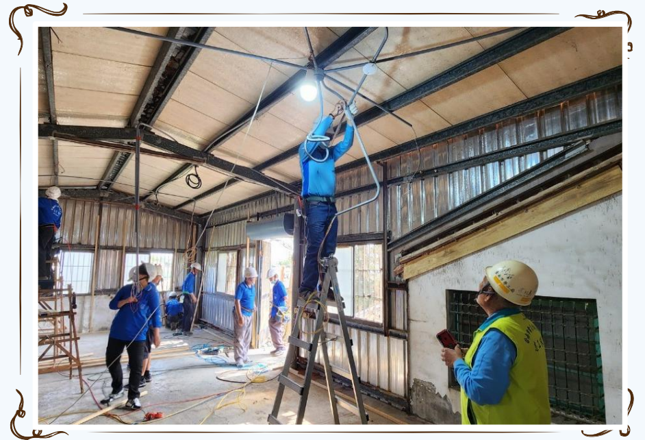
電氣志工施作
