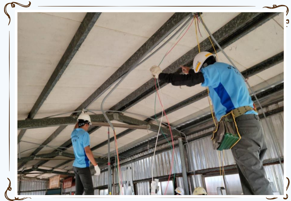
電氣志工施作
