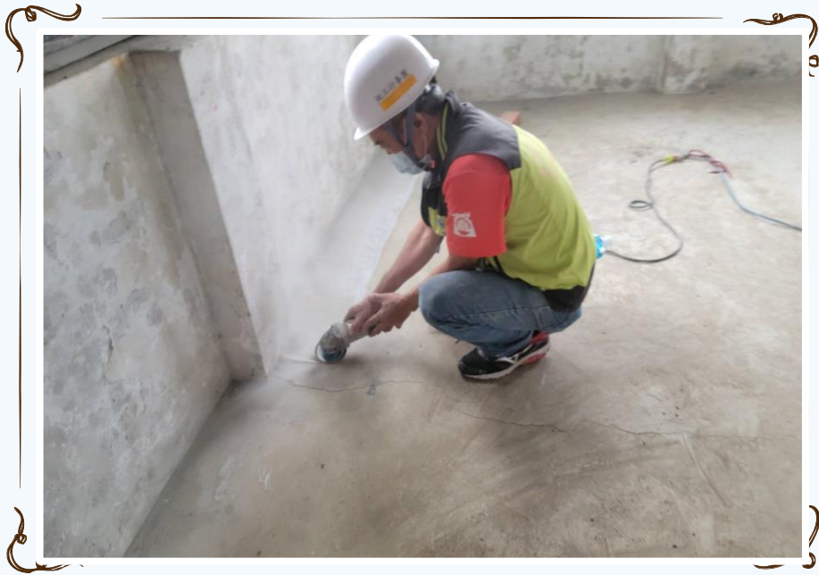
泥水志工施作
