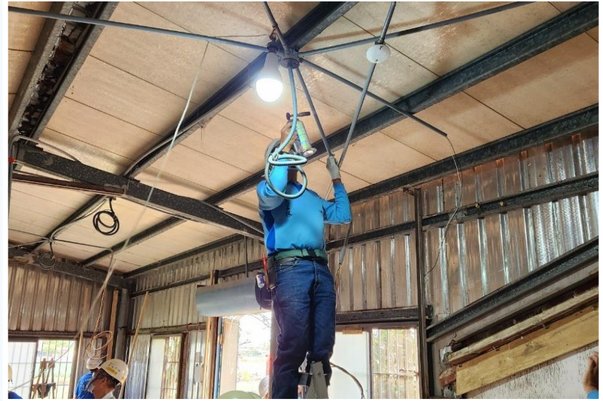
電氣志工施作
