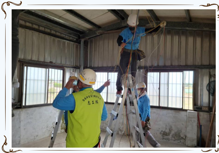
電氣志工施作
