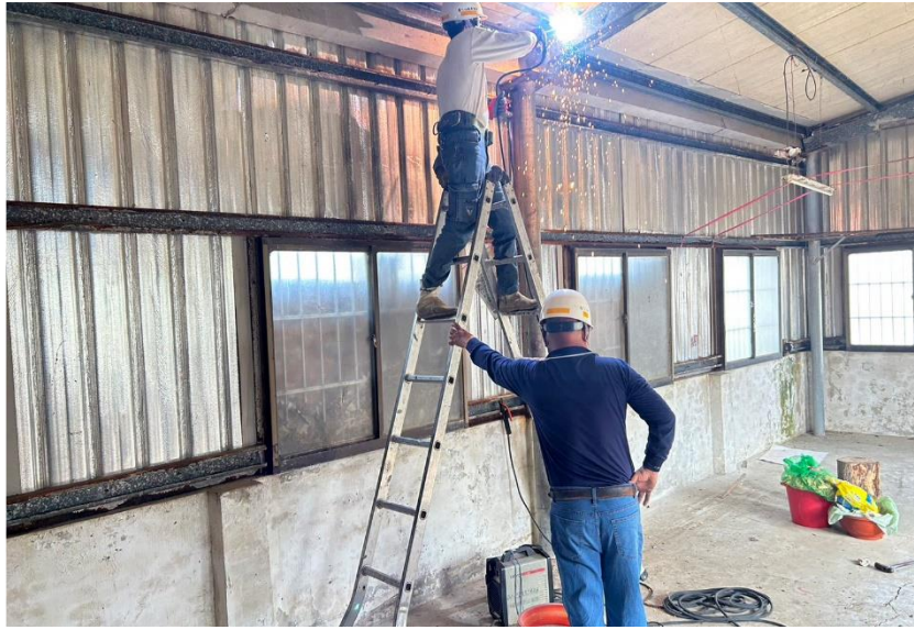
金屬志工施作
