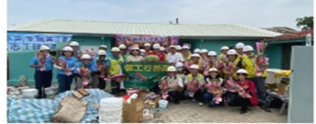
做工行善團成員在現場修繕屋頂，展現活動熱誠與公益精神。 (做工行善團提供)
