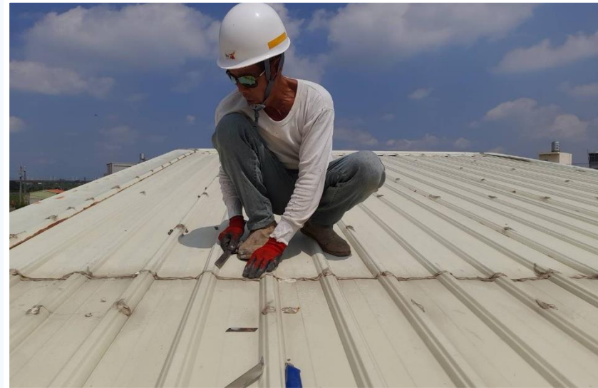
金屬志工施作
