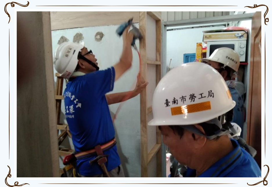
木工志工施作
