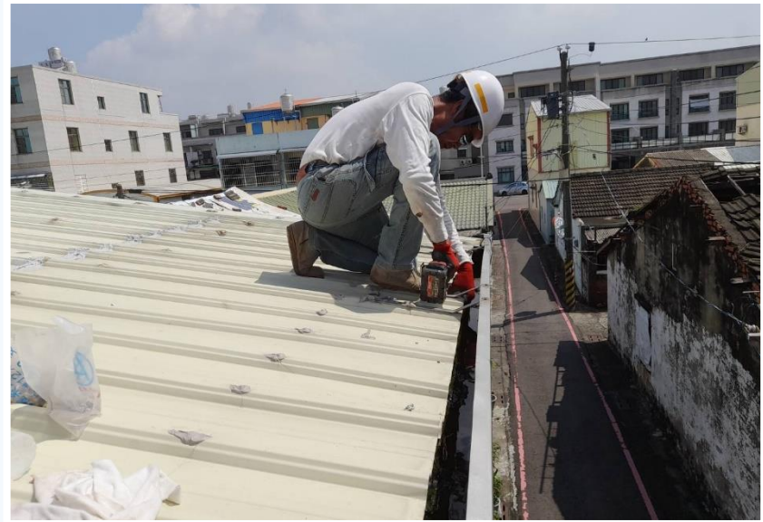
金屬志工施作
