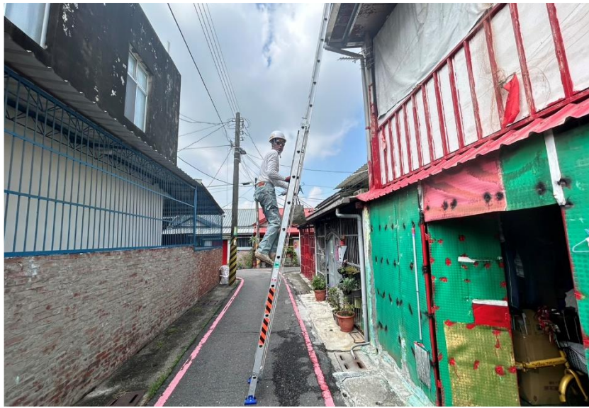
金屬志工施作
