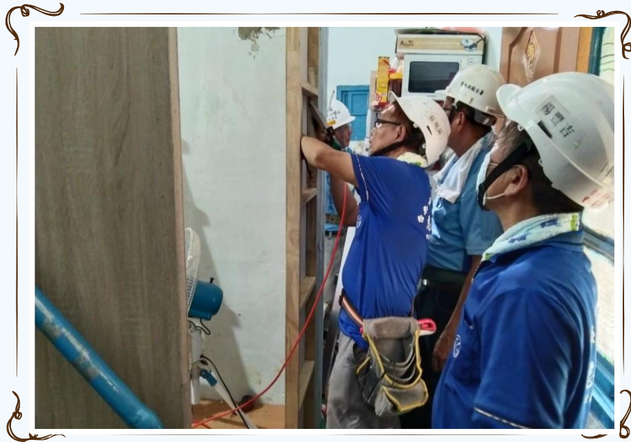
木工志工施作
