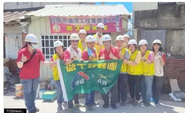
南市勞工局做工行善團趕工不分假日，眾志成城，麻豆地震坍塌屋修繕完工。（記者李嘉祥攝）
