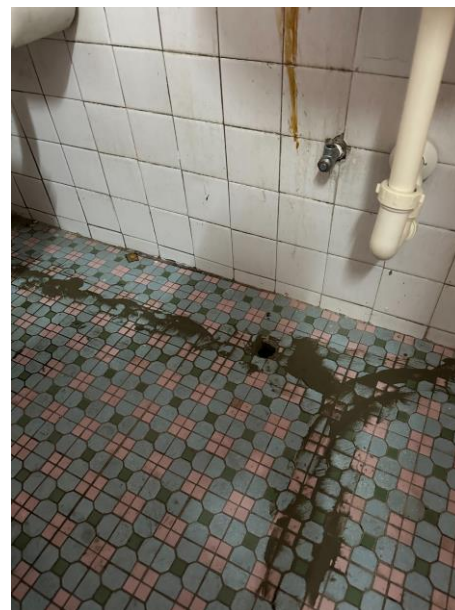
浴室地面修繕後
