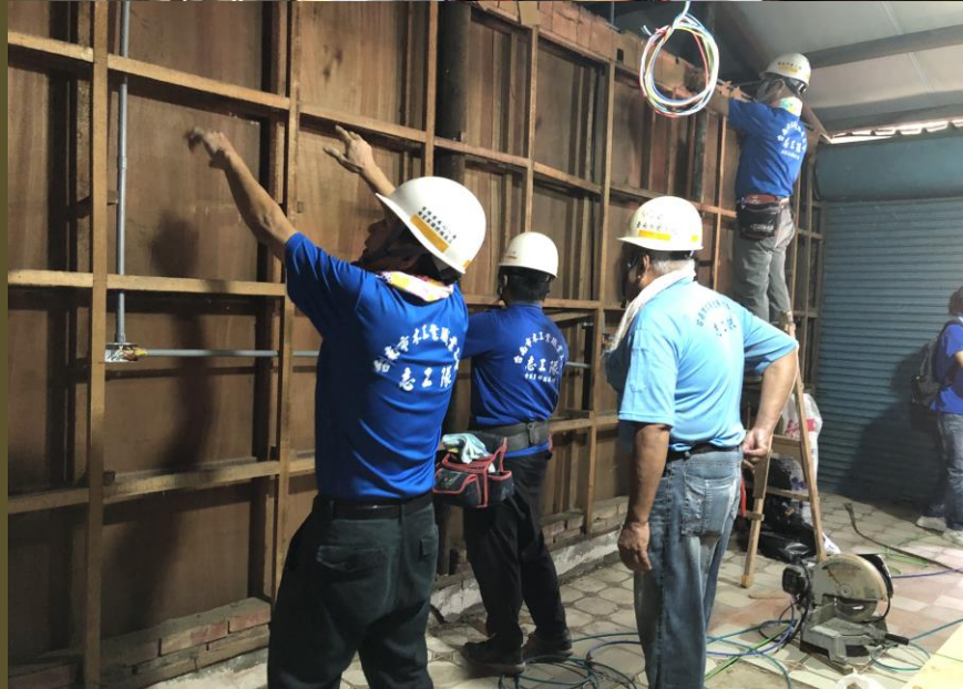
112.08.27牆壁美化板、天花板輕鋼架施工(木工)
