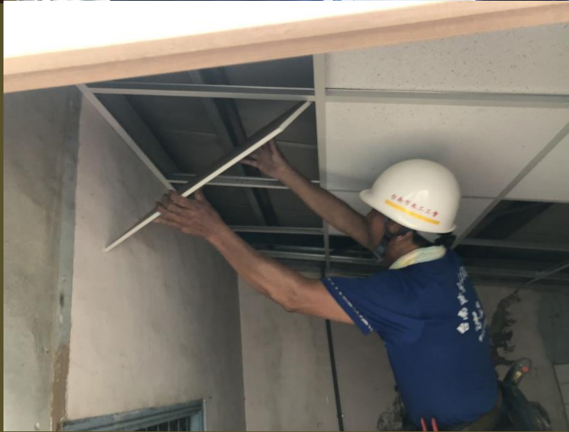
112.08.27牆壁美化板、天花板輕鋼架施工(木工)
