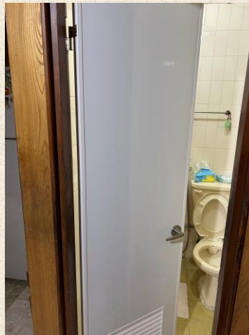
浴室門修繕後
