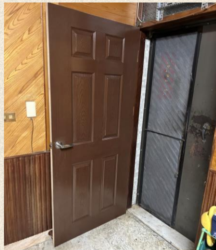
客廳門修繕後
