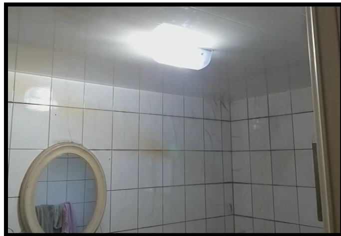
浴室天花板修繕後
