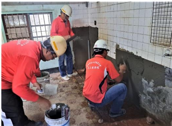
台南市泥水業職業工會志工前往學甲替弱勢戶粉刷修補牆壁。(勞工局提供)
