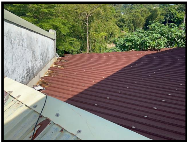
屋頂鐵皮修繕前
