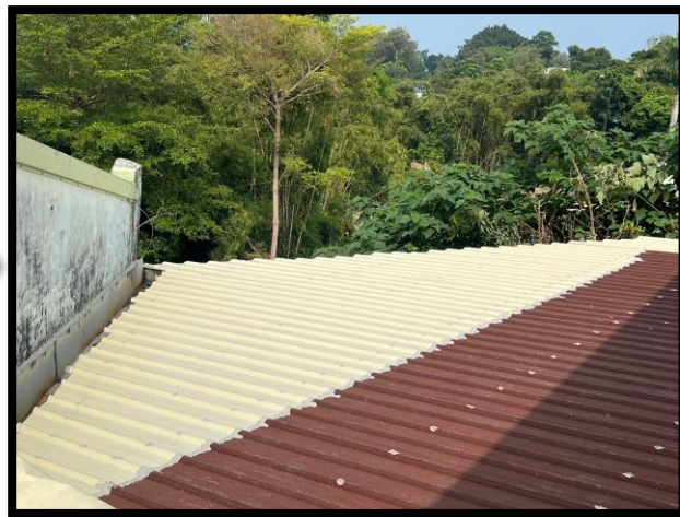
屋頂鐵皮修繕後
