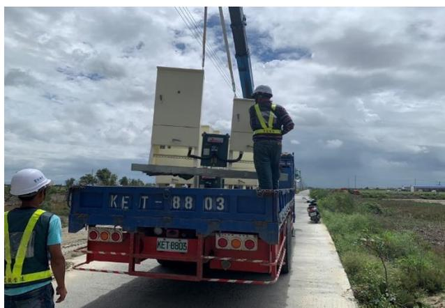
臨時水電-分電盤基礎座吊裝定位
