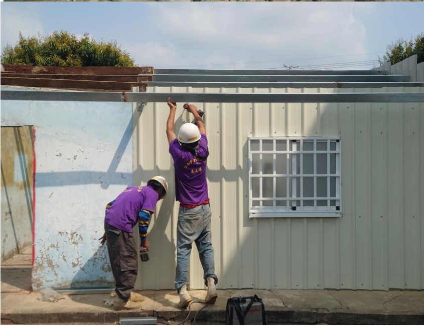
113.3.5-3.7屋頂鐵厝、牆壁鋼板施工(金屬)
