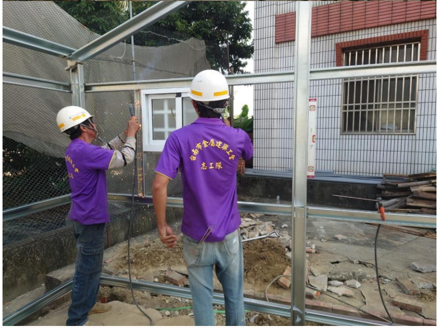
113.3.5-3.7屋頂鐵厝、牆壁鋼板施工(金屬)
