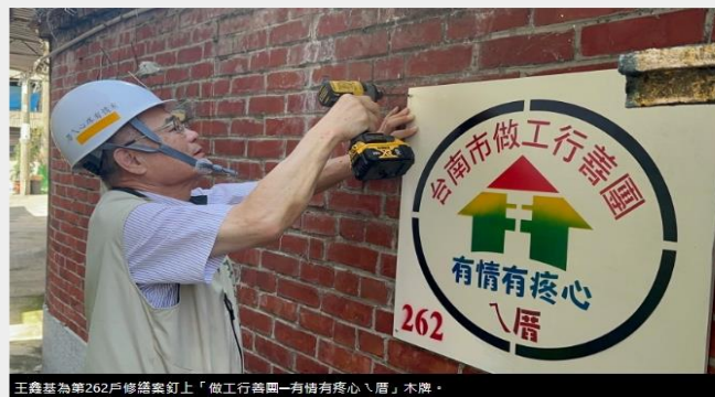
王鑫基為第262戶修繕案釘上「做工行善團—有情有疼心」木牌。
