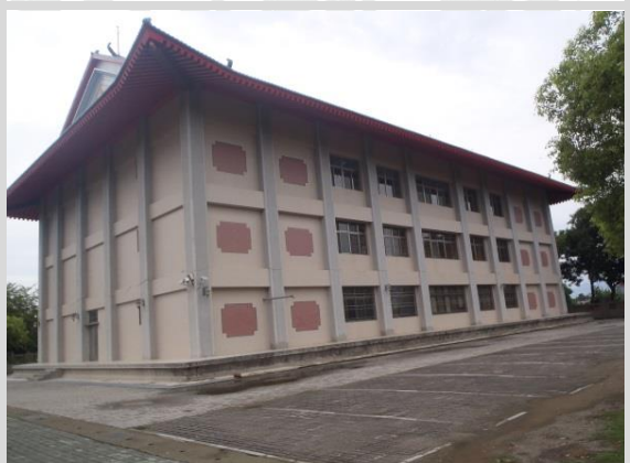
臺南市善化區第一公墓納骨堂
