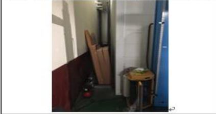
說明：作業場所放置可燃廢棄物
