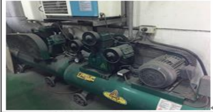
說明：空壓機(第二種壓力容器)缺少檢點表
