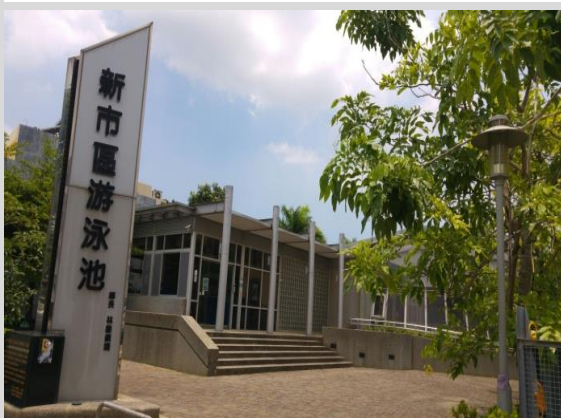
新市區游泳池
