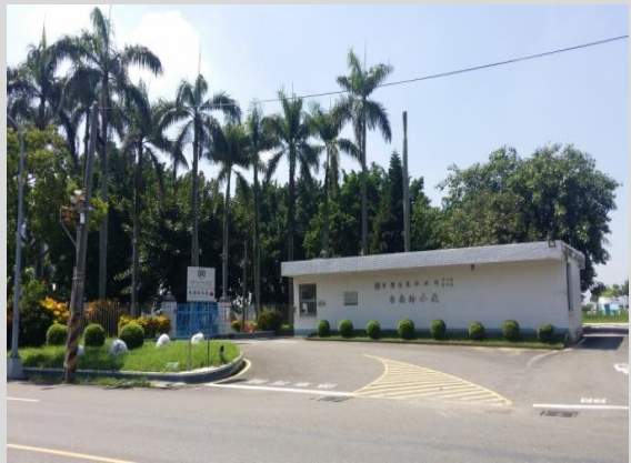
自來水公司臺南給水廠
