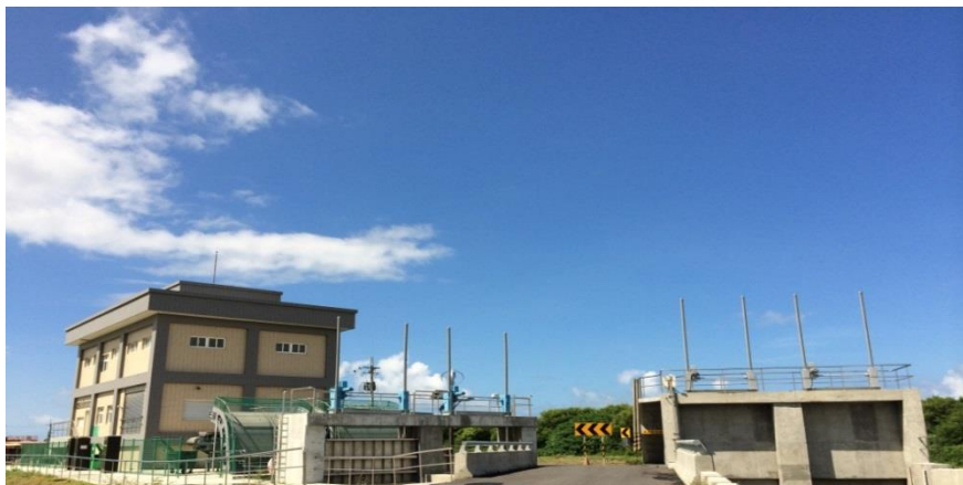
本淵寮及海尾寮A抽水站
