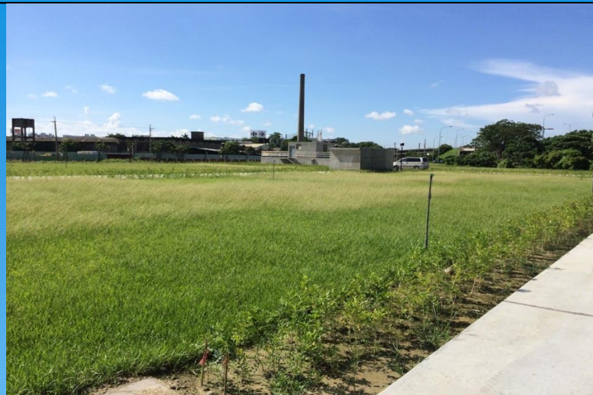
萬代橋生態礫間淨化工程
