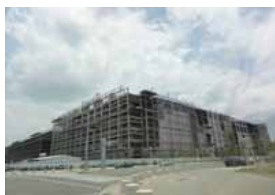
園區興建中廠房（和鑫）
