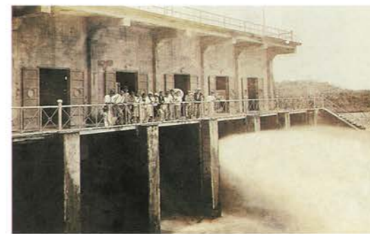
▲烏山頭水庫放水口
