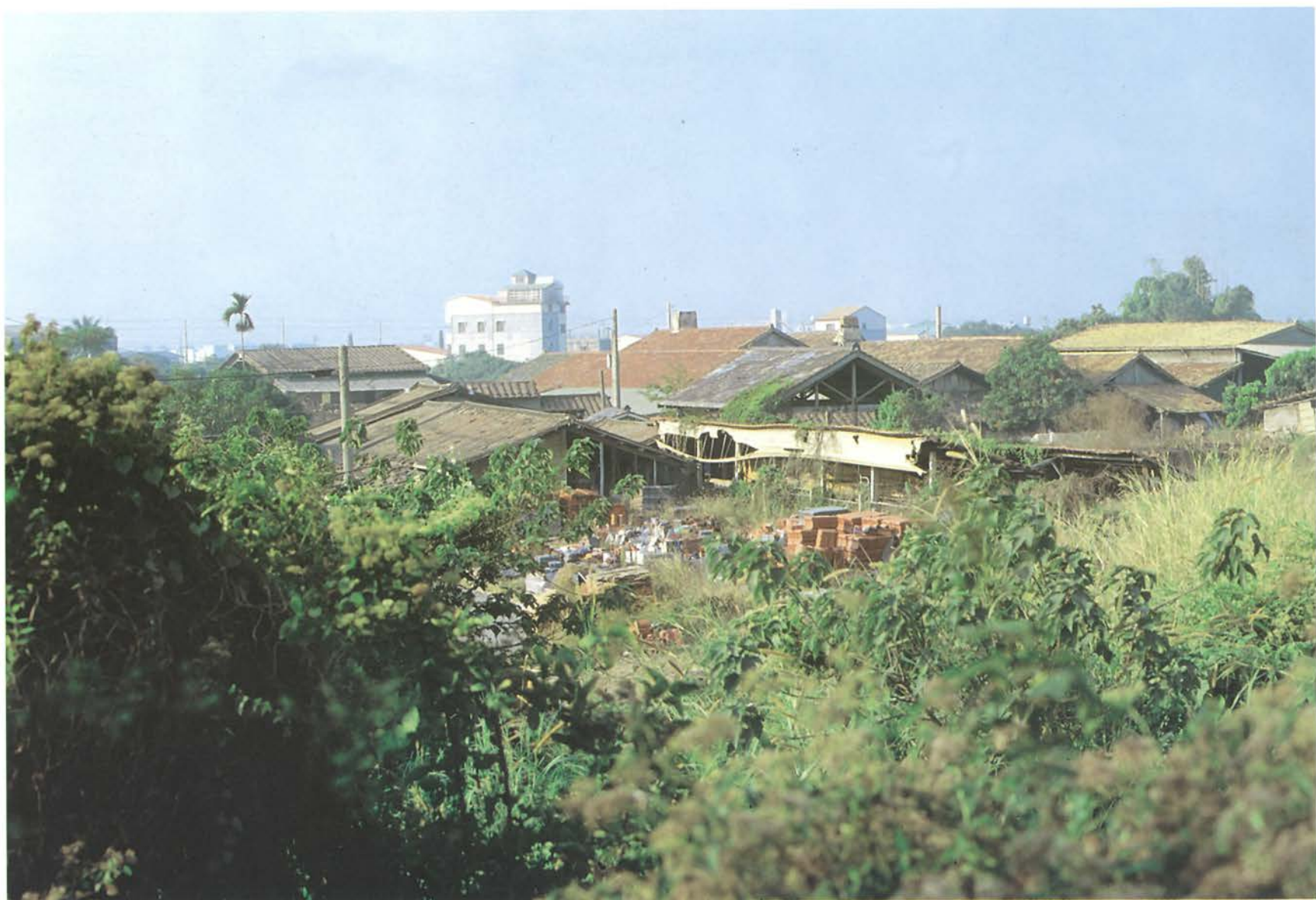
▲遠眺大統製瓦工廠全景
