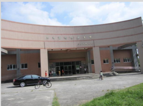
玉井區綜合體育館
