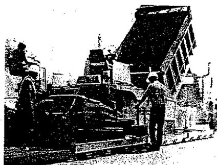
圖 5 鋪築瀝青路面
