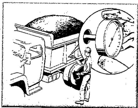
圖 4 量測瀝青混凝土溫度
