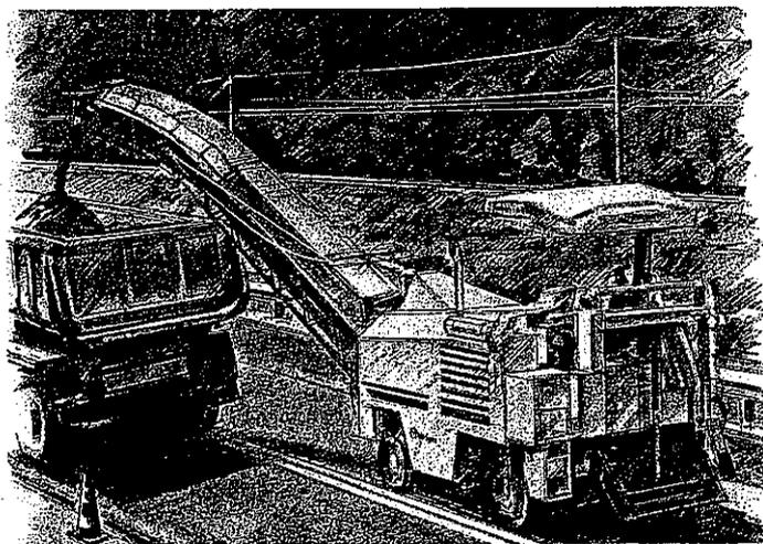
圖 1 損壞舊瀝青路面刨除施工
