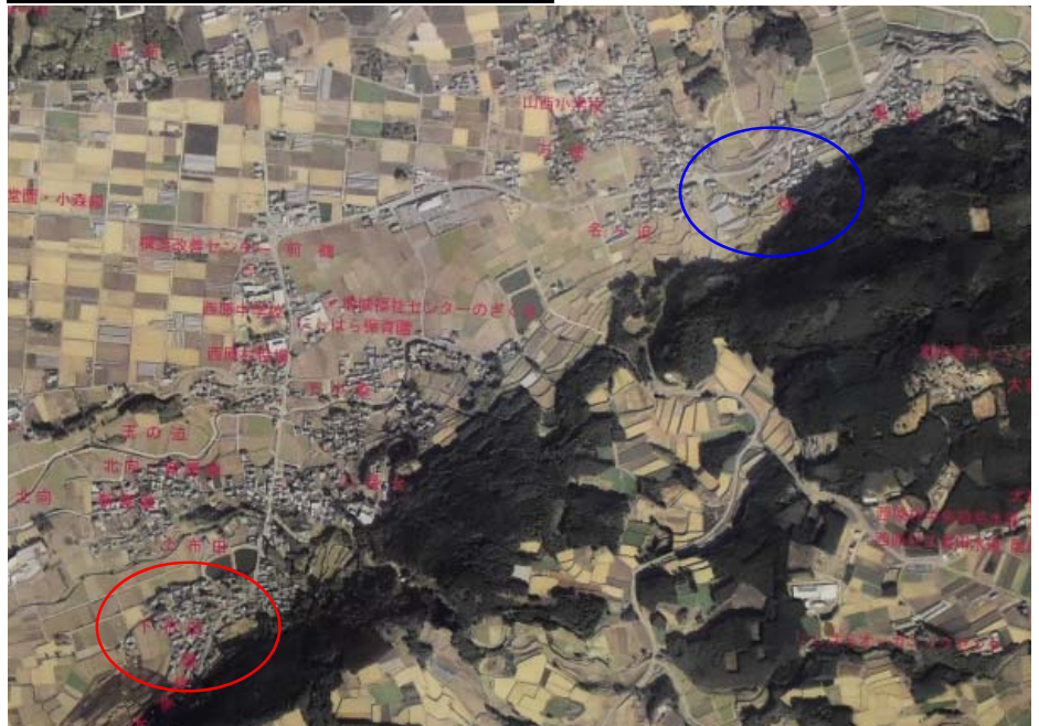
西原村被災状況 布田 (ふた) 地区・風当 (かざて) 地区
