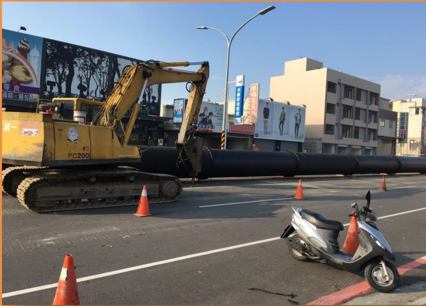
崑大路明管緊急供水工程
