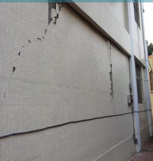
未補強：左鎮區公所
