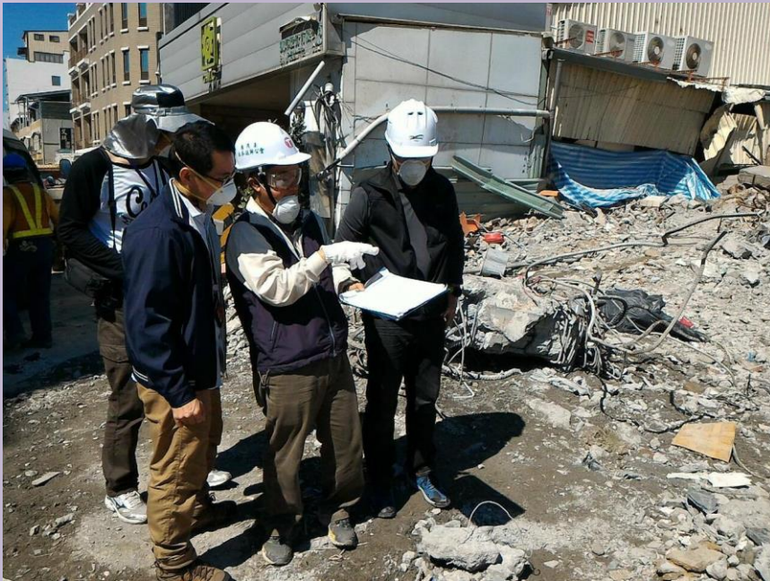
委託技師辦理危險建築物緊急評估
