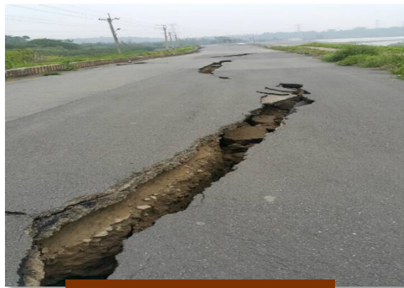
二溪橋北側防汛道路
