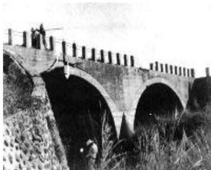
新化鎮思橋(改建後更名為深坑橋，中山路上，台 20 號公路)北端橋拱中央斷裂，斷裂處之北側橋體上升 (陳培源教授提供)。
