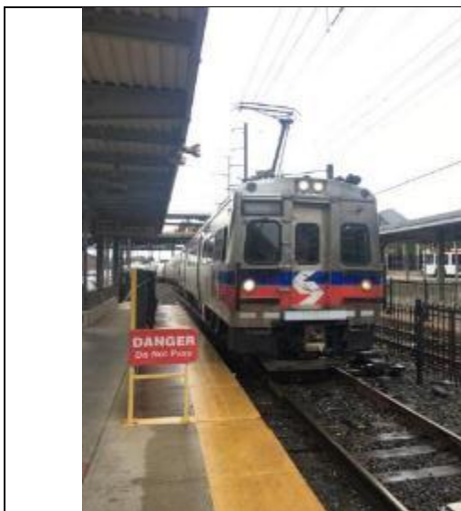
郊區通勤鐵路採架空線供電，郊區車站
