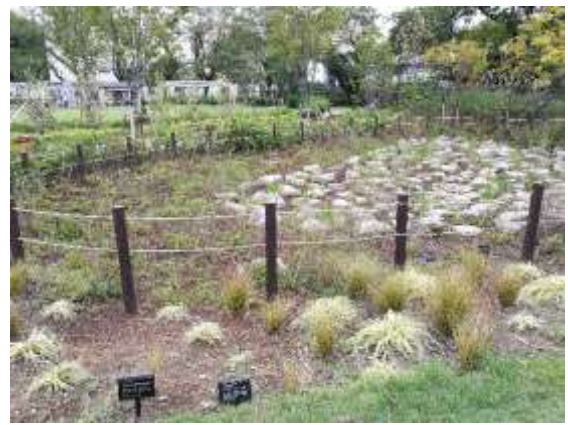
雨水花園四周設置簡易圍欄以維護積水時的居民安全
