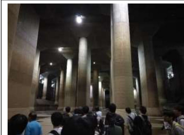
有「地下宮殿」之稱的調壓水槽
