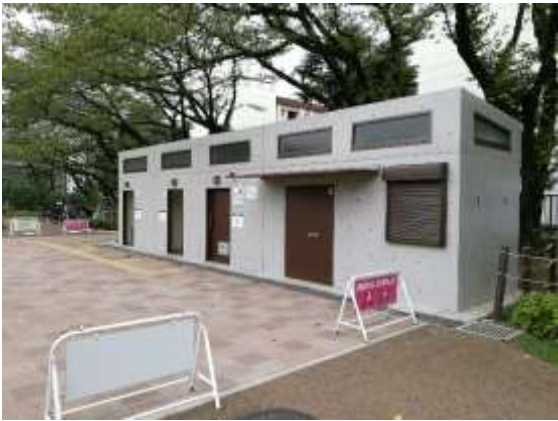
公共廁所與公園備品倉庫
