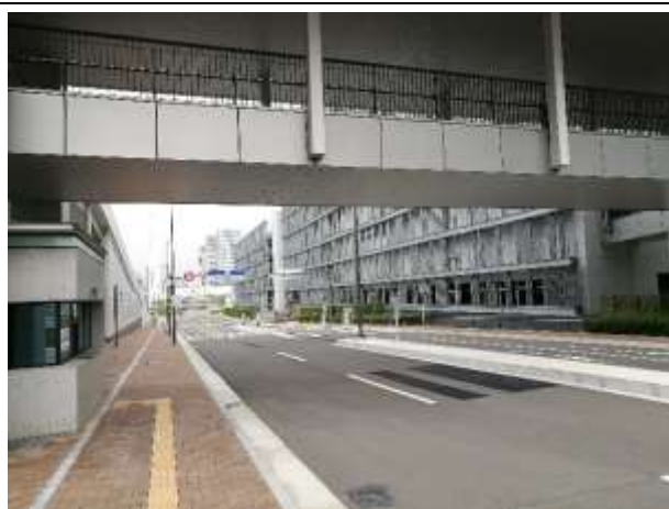
跨越出入口、串聯兩棟建物的人行天橋
