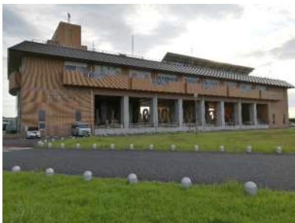
排水機場建築
