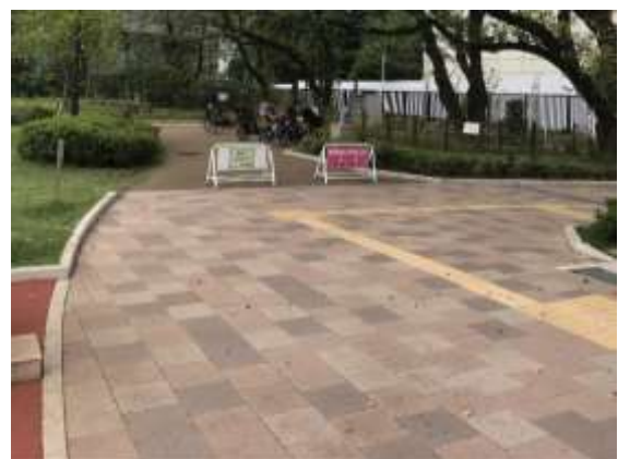
混凝土磚鋪面。以三種相近大地色系 做跳色處理，可看出其設計細膩之處
