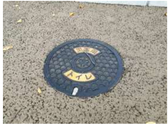
防災廁所人孔蓋，災時於周圍加裝布簾等遮蔽物即可使用
