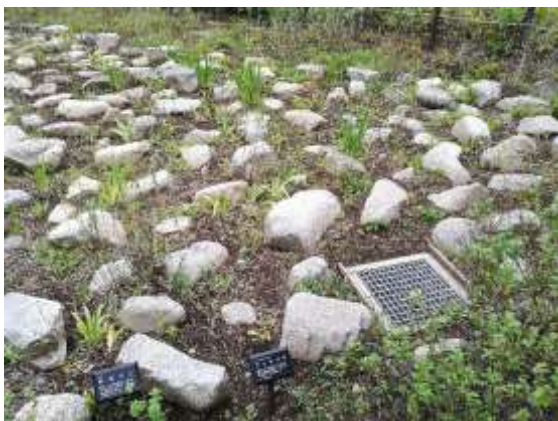
雨水花園內種植耐水植栽，同時以大粒徑石組做為地景的一部分
