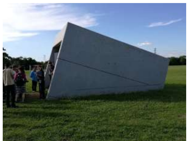
調壓水槽入口
