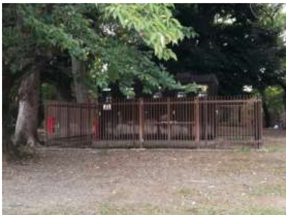
電箱等設施不另多做設計， 自然隱沒在環境中
