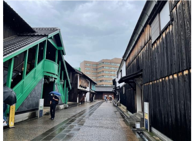
▲圖 25、重建復原的建築與街道
