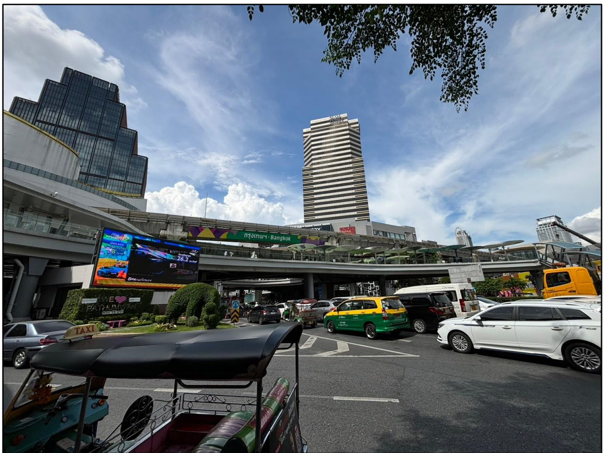
圖36 由地面層眺望 OneSiam 高架空橋
