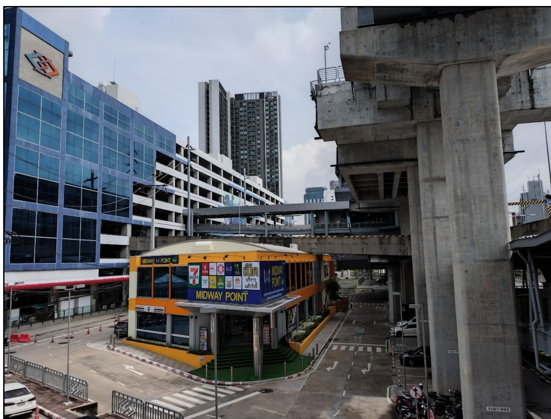
圖26 樂拋站轉乘停車場與穿堂層連通空橋
