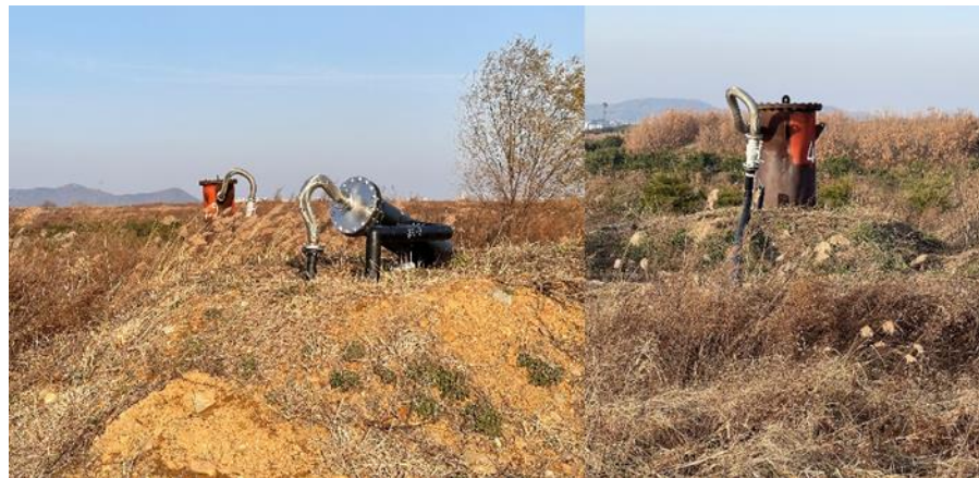
圖 64 首都圈掩埋場沼氣回收及捕捉設施
