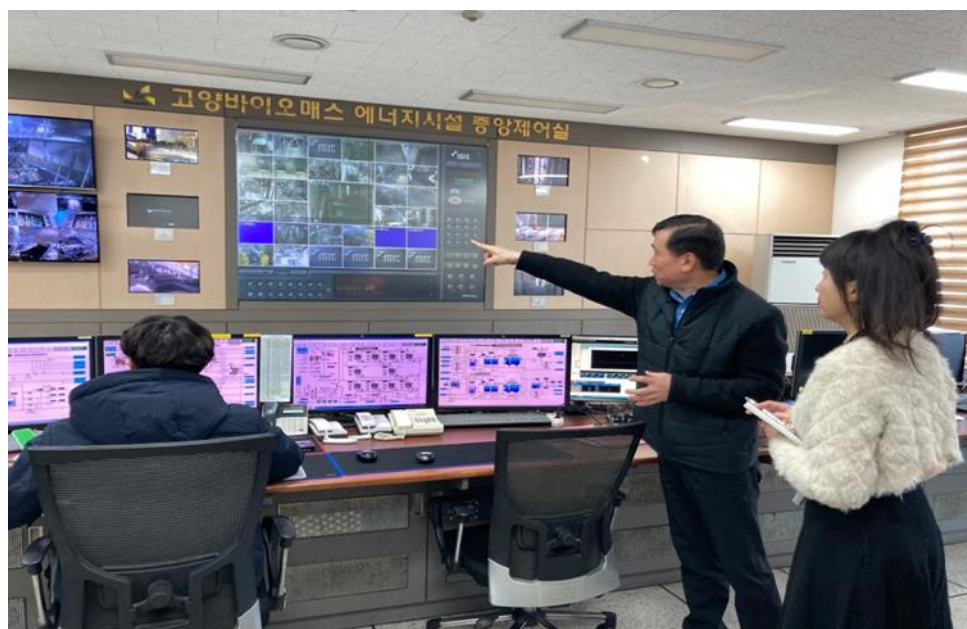
圖 81 高陽生質能源設施中控室觀察進料情形及操作解說
