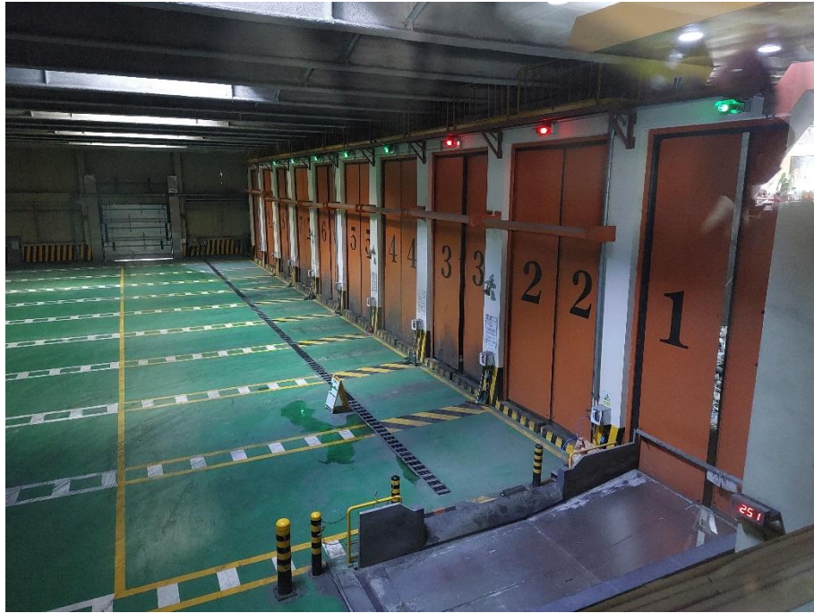
圖 53 麻浦資源回收設施廢棄物傾卸平台及落地檢查作業區
