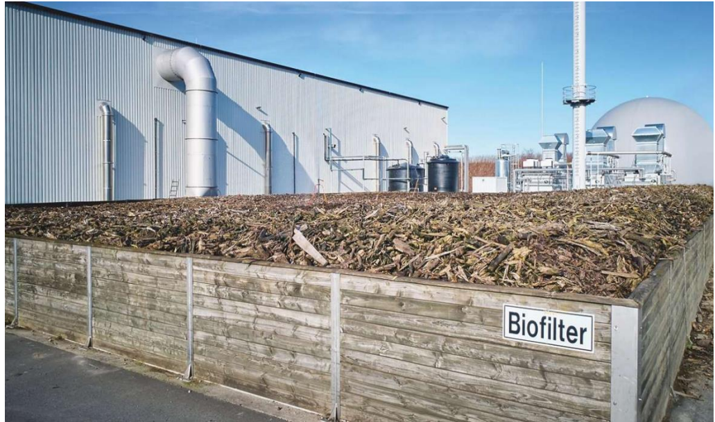
圖 18 廢木材回收運用於生質能發電
