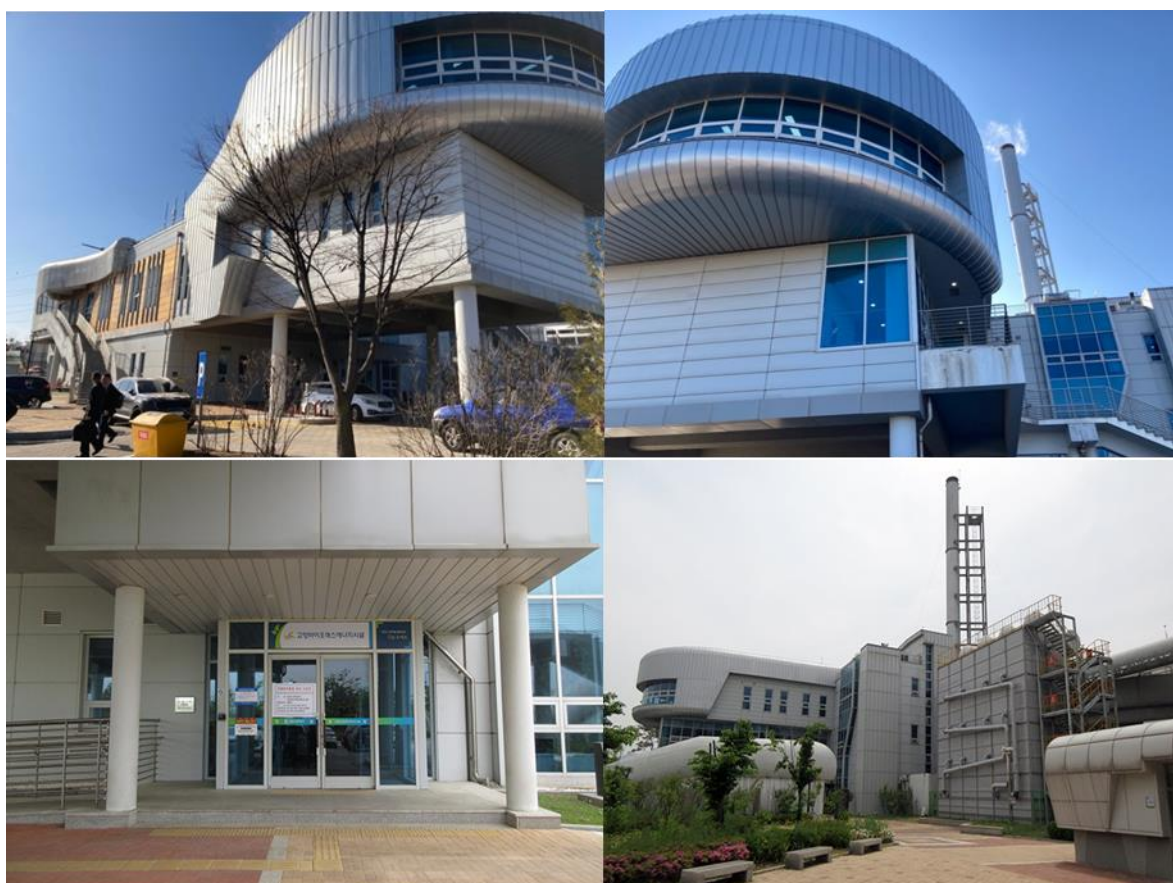
圖 78 高陽生物質能源設施建物外觀
