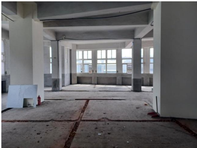
2樓室內環境整修
