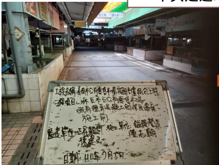
中央走道地面整修
