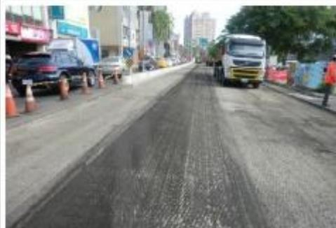
(2) 鋪設瀝青新工法：透過9公尺大平衡樑及3組超音波偵測，提升道路鋪設平坦度
