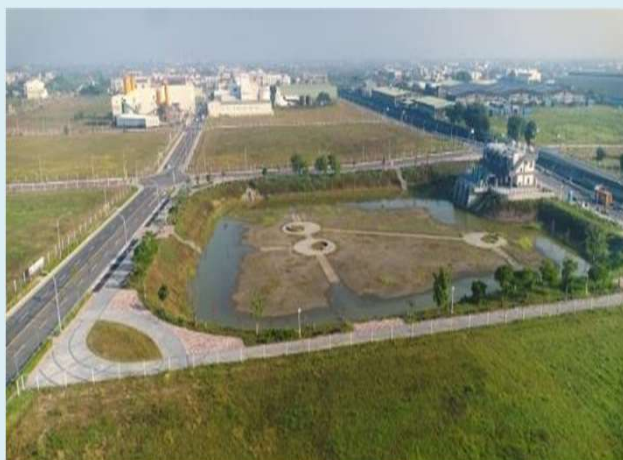
麻工、麻柚兩座抽水站
