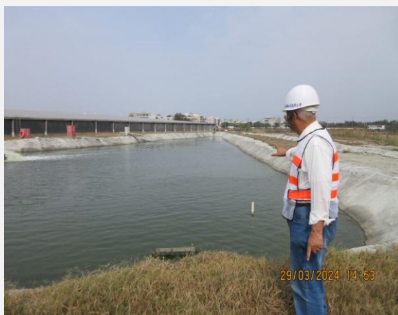
汛期前滯洪池水位預降
