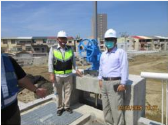
抽水機電動閘門檢查
