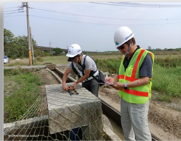
基地出流水閘門
