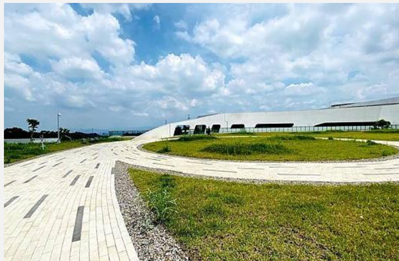
低衝擊開發設施(透水鋪面、生態池)
