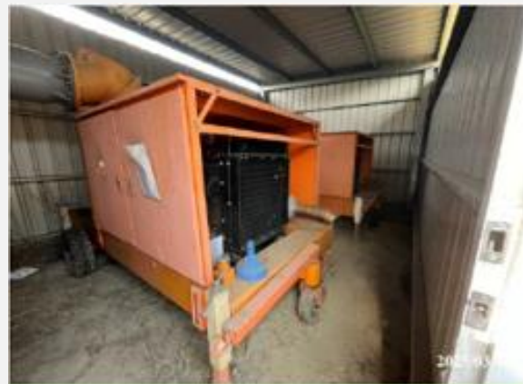
抽水機定期保養維護
