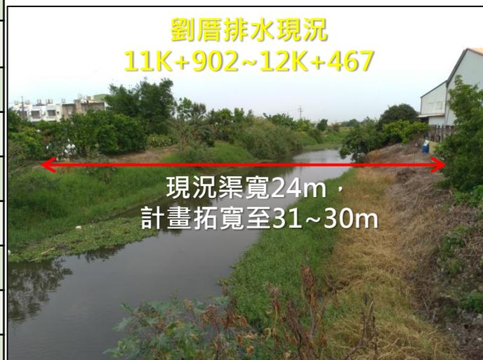
劉厝排水9K+271~13K+800預計整治長度**4529公尺**，現況渠寬5~40公尺，計畫拓寬至7~42公尺，並含雙岸水防道路、護岸堤頂高2.27~3.65m
