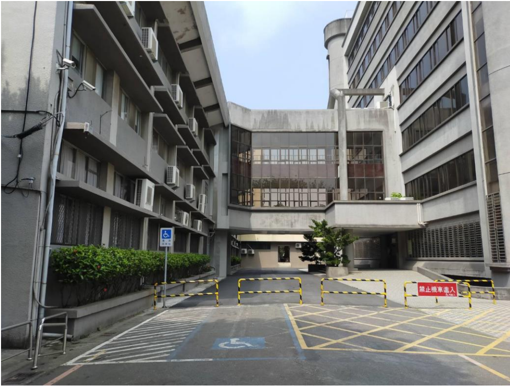
(八) 圖 13-民治市政中心南瀛大樓及地下室出入口-3
