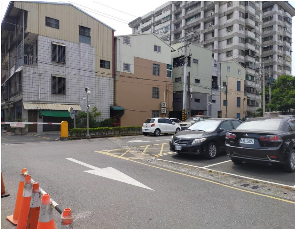
(七) 圖 12-民治市政中心員工停車場-2
