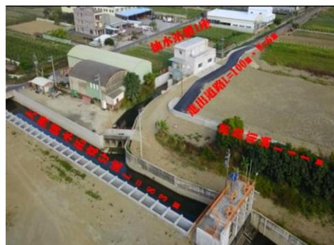
大灣抽水站整體用地取得及都市計畫變更完成後，本府再獲得內政部營建署前瞻計畫補助及本府自籌經費合計 1 億 2,000 萬元，將於今(108)年續辦大灣抽水站第二期工程設計作業，初步規劃抽水站房 1 棟、1 萬噸滯洪調節池、3 部 4cms 豎軸式抽水機及 1 部 4cms 備用機組，使大灣抽水站總抽水量達到 26cms，預計 109 年底前完成。此外，大灣排水治理工程目前亦積極施工中，預計 108 年中旬完工，該區域工程陸續完成後，防洪能力將再提昇。
