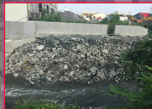
六河局新建工程(左岸)防汛缺口(已先行用太空包封補)及河道阻礙
