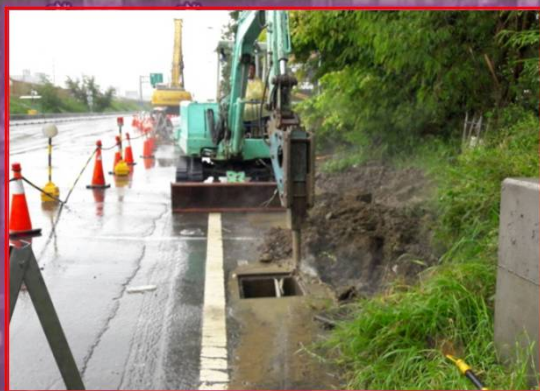
既有側溝與無名箱涵打通連接
