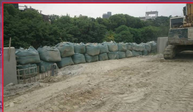
六河局新建工程(左岸)防汛缺口(已先行用太空包封補)及河道阻礙
