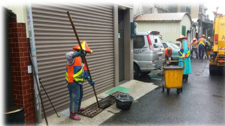
道路側溝清淤
