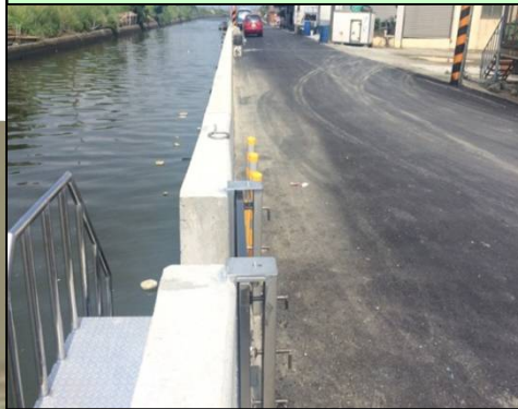
六成中排一航道護岸加高
